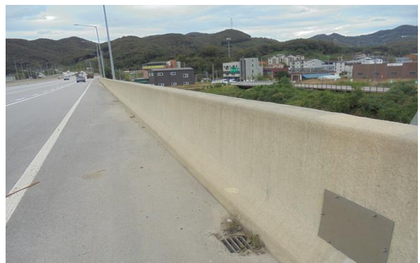
난간 및 연석 전경
