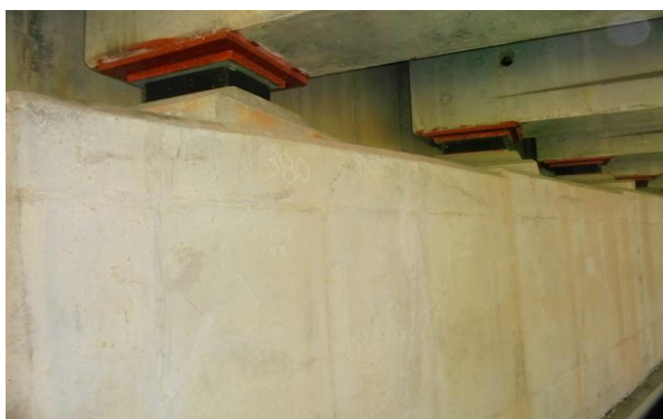
교량 받침 전경
